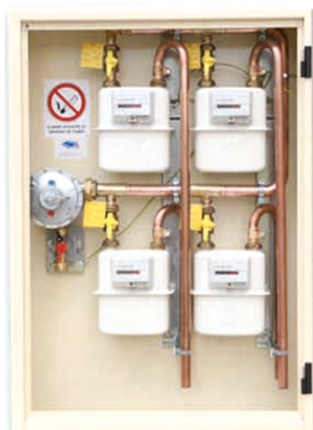
Ex : 4 comptages Détente collective 4 Cpt G4
